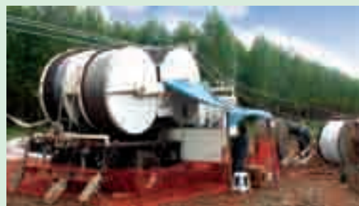
Cabo e Emenda Preformada passando pelas roldanas no lançamento.
