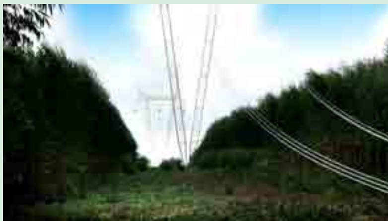
Vista do lançamento do cabo na LT.
