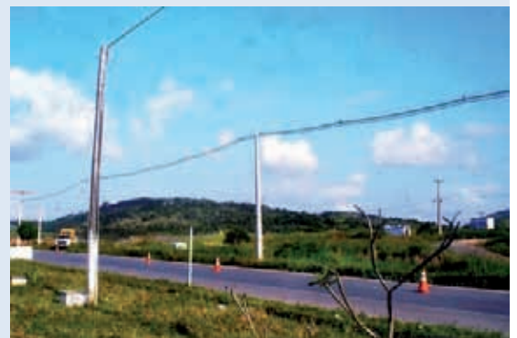
Rede Compacta instalada.
